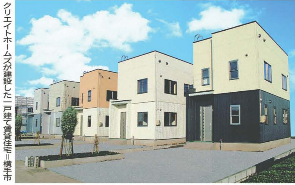
クリエイイトホームズが建設した「戸建て賃貸住宅」棟の様子
